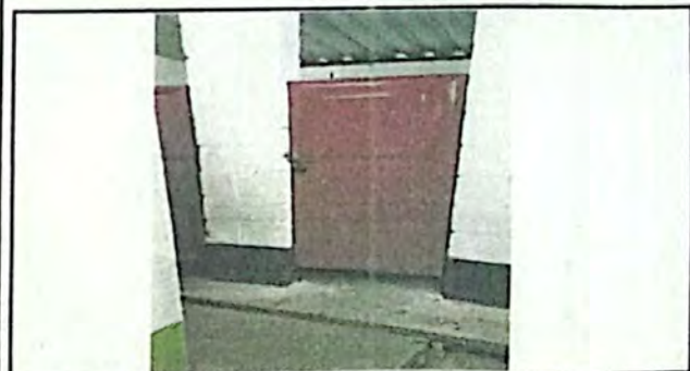
Foto 5: Sustrución de 1 puerta del sanitario.
