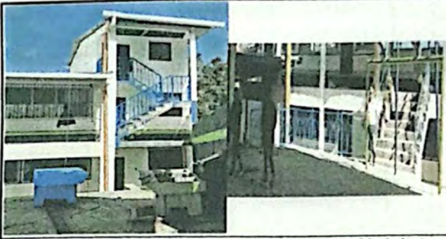
Foto 6: Sustrución de barandales en area y gradas del establecimiento.
