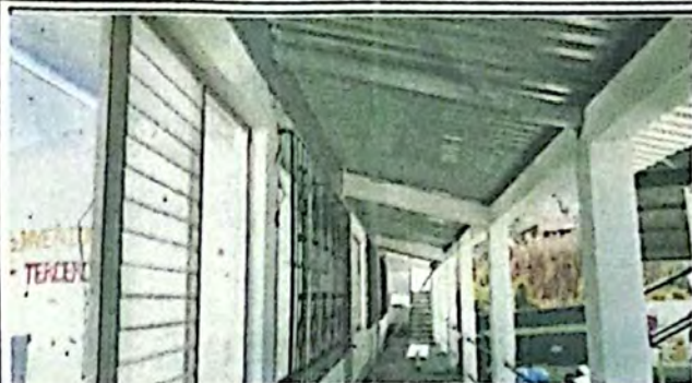
Foto1: Sustrución de lamina troquelada aluzin calibre 26 en pasillo del modulo del establecimiento.
