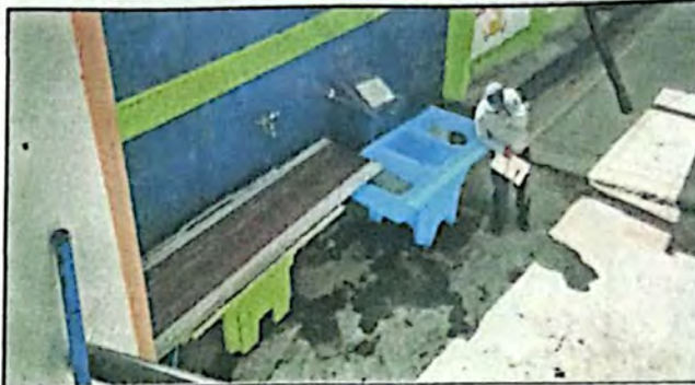
Foto 4: Sustrución de 1 pila de dos lavaderos en el patio del establecimiento.
