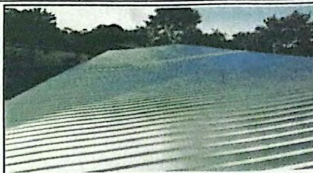
Foto 2: Sustrución de techo completado del modulo 2.
